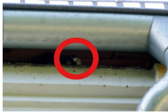
Am Schlosspark 4,6, 12 u. den anderen Gebäuden sind BP in der Traufe, wo das Gitter defekt ist.
