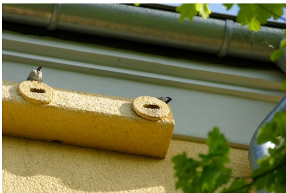
2 BP in einem Nistkasten Wolfshagener Str. 69 rechts oben Dachkante.
